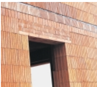
Linteau avec pré-linteau et briques de compensation.
